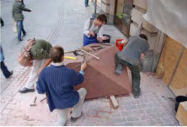
Abbildungen 9: Sandsteinkubus in den ersten Arbeitsschritten. Fotos: Daniel Häni
